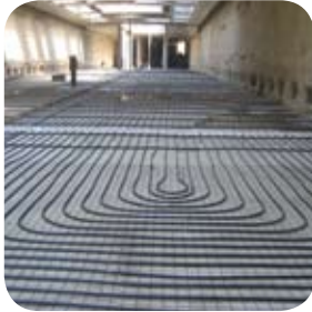
Eine Erdwärmelanlage entsteht © TU Wien
