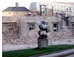
Abriss des alten Lehartrakts
