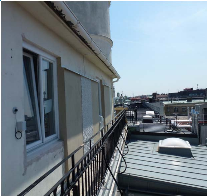
Abbildung 1 (links): Testflächen am Geodäten-Kopfbau der TU Wien.
